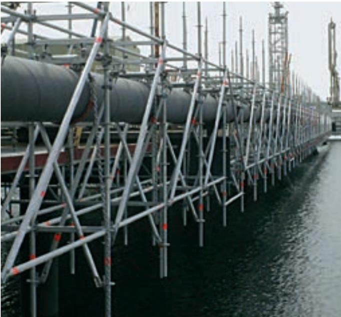
Hängegerüst an Rohrleitung – angeschlagen mit Ketten an Hängegerüst-Adaptern
