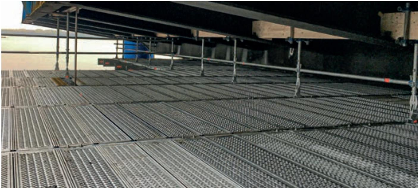
Stolper- und spaltfreie Ausdeckung mit Serien-Stahlböden
