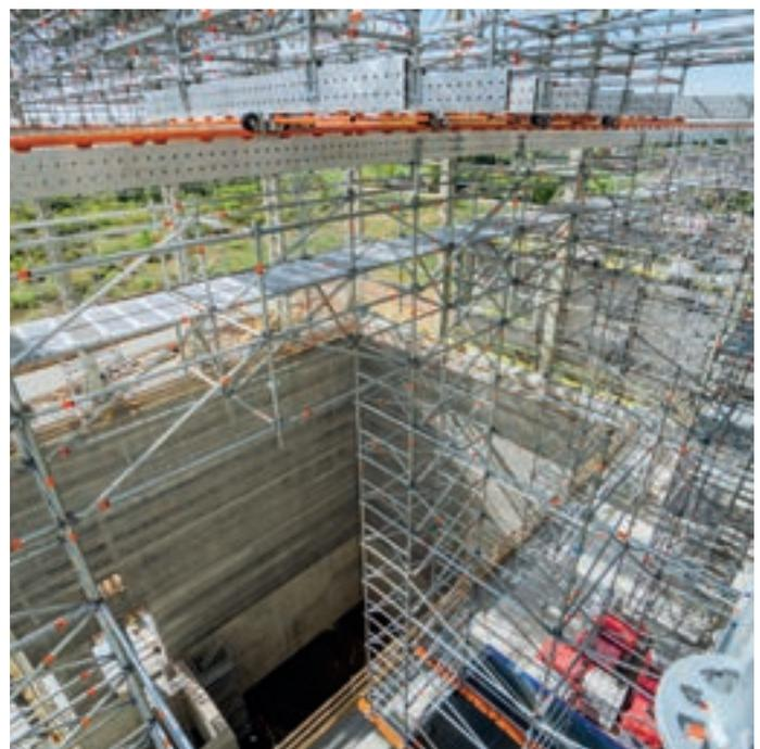
Traggerüst TG 60 in Kombination mit dem Aluminium-Träger FlexBeam und dem Allround Fachwerkträger beim Neubau einer Industrieanlage
