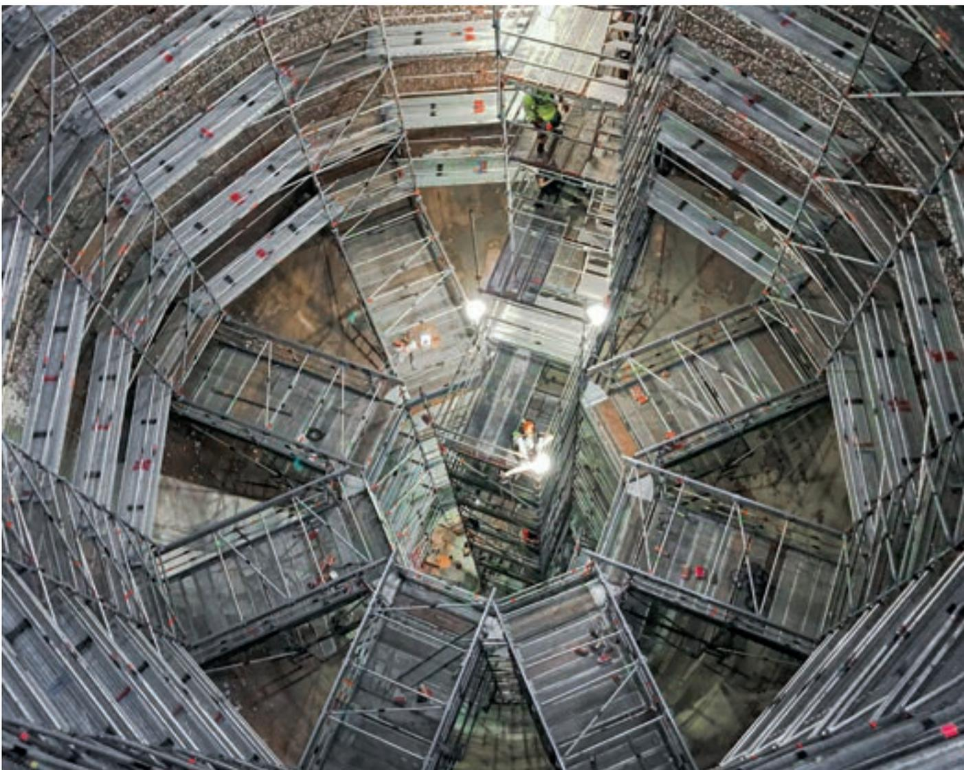
Großansicht der Boiler-Innenrüstung mit dem Aluminium-Träger FlexBeam
