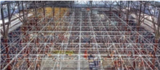
Deckengerüst mit Allround Fachwerkträger in einer Halle – die Bodenfläche bleibt frei, wodurch der Betrieb fortgesetzt werden kann
