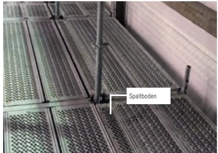
System-Spaltböden mit Keilköpfen zur Schließung des Übergangs zu Konsolflächen
