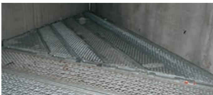
Dreiecks- und Trapezböden zur höhengleichen Ausdeckung von 45-Grad-Innenecken
