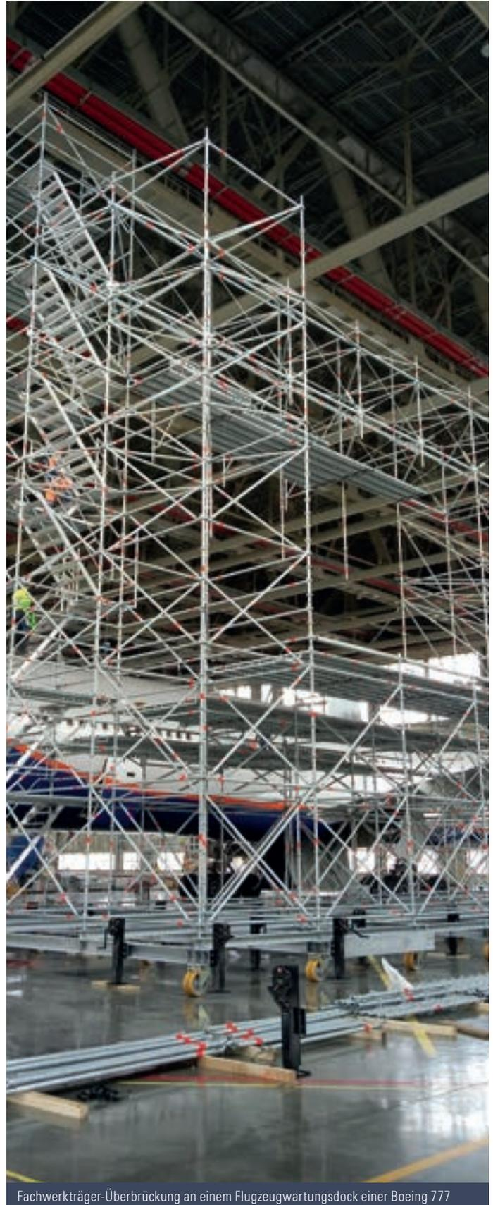
Fachwerkträger-Überbrückung an einem Flugzeugwartungsdock einer Boeing 777
