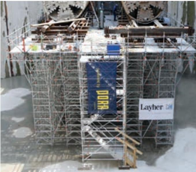
Lastplattform aus Allround Traggerüst TG 60 mit integriertem Podesttreppenturm für das Absetzen der Bohrköpfe
