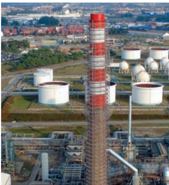
Rundrüstung mit AllroundGerüst an einer Raffinerie-Kolonne
