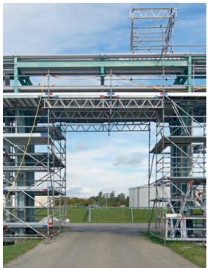
Überbrückung mit Stahl-Systemgitterträger 450 LW aus dem Layher Zubehör
