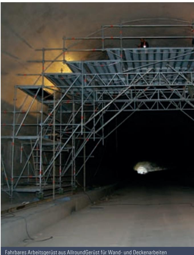
Fahrbares Arbeitsgerüst aus AllroundGerüst für Wand- und Deckenarbeiten
