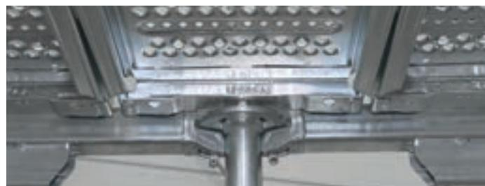
Stahlböden erlauben ein Ausdecken über der Lochscheibe
