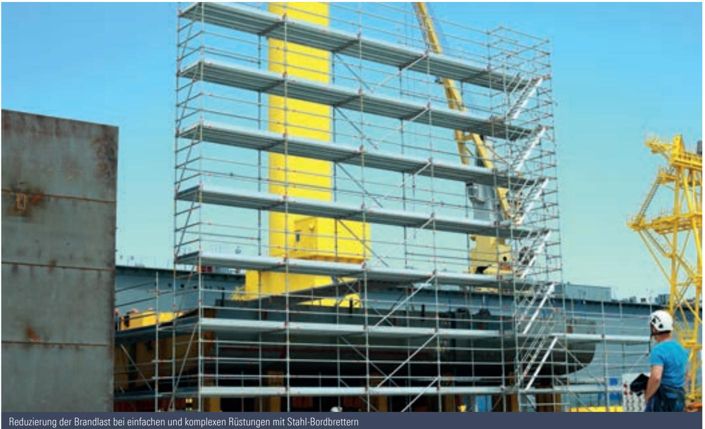
Reduzierung der Brandlast bei einfachen und komplexen Rüstungen mit Stahl-Bordbrettern
