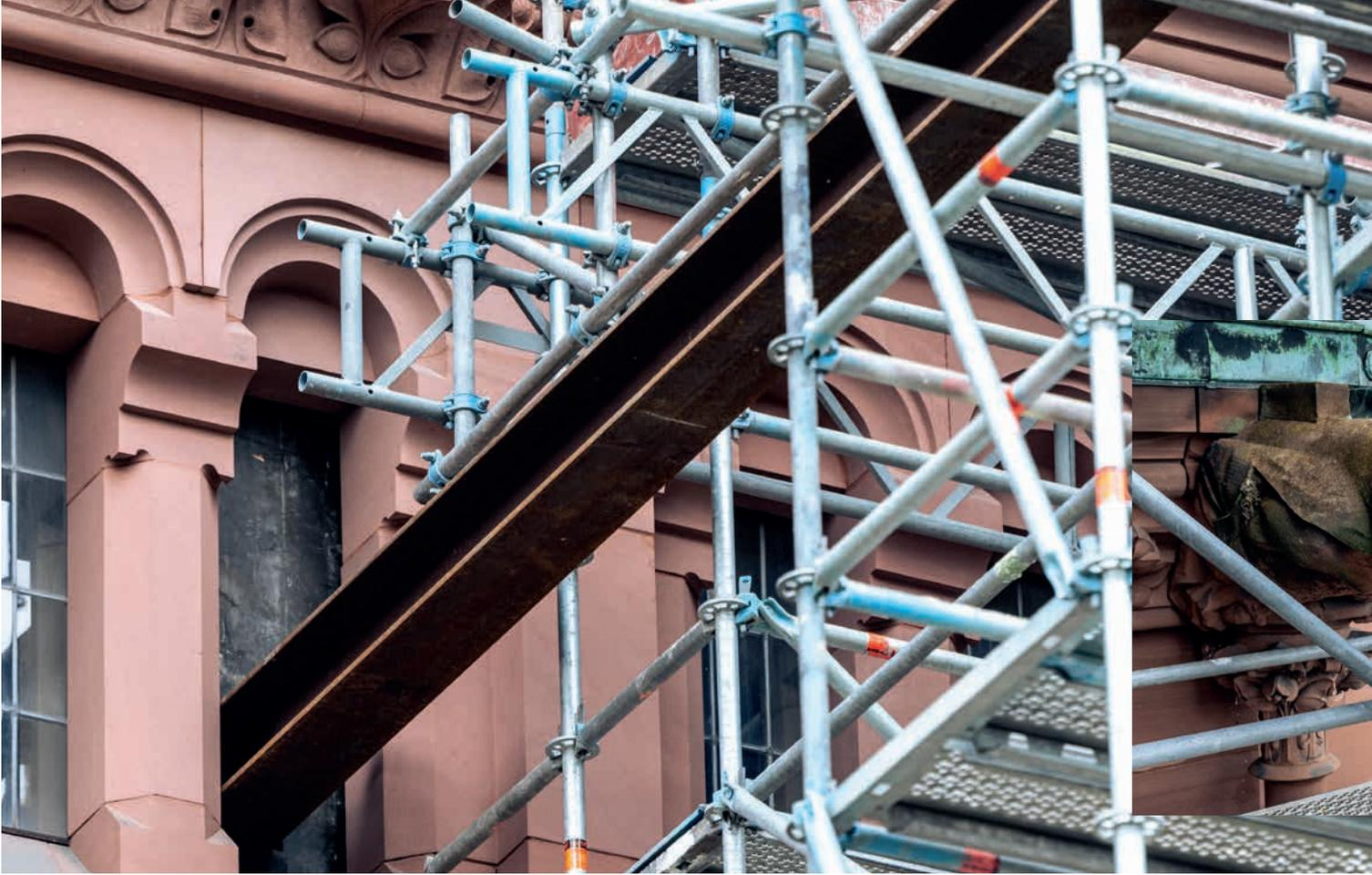
*Um die Fassade nicht mehr als unbedingt nötig zu beschädigen, führen die Planer Stahlträger durch die Fenster des Gebäudes und lasten sie auf dem Traggerüst ab.*
