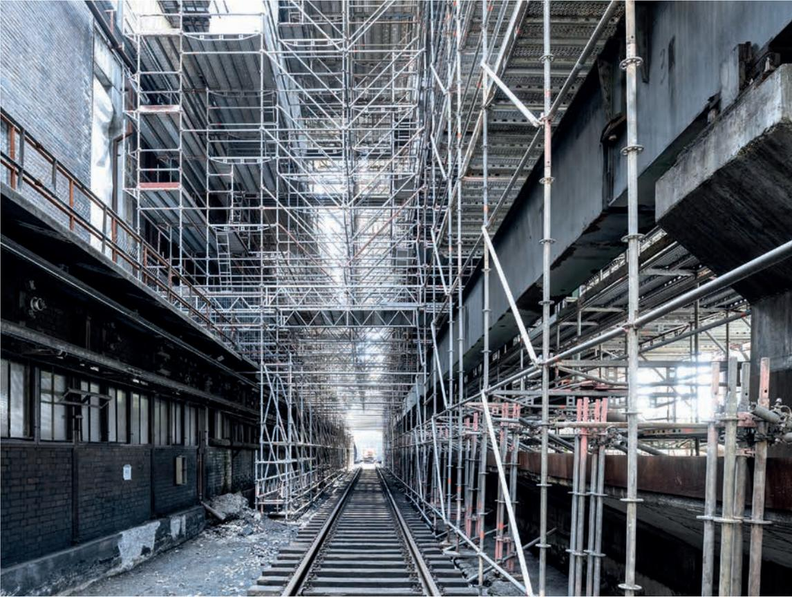
Ein 8.000 m<sup>3</sup> großes Raumgerüst im Inneren der Halle ermöglicht den einfachen und sicheren Zugang für die Sanierungstruppe.
