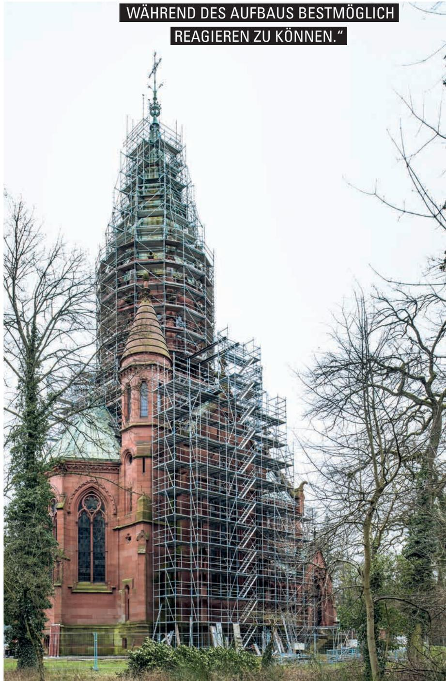
*Bevor die typische Sandsteinfassade der eigentlichen Kirche saniert wird, steht der Turm an. Daher sind die unteren Teile zu Beginn nur als Traggerüst für das eigentliche Arbeitsgerüst um den Turm konzipiert.*
