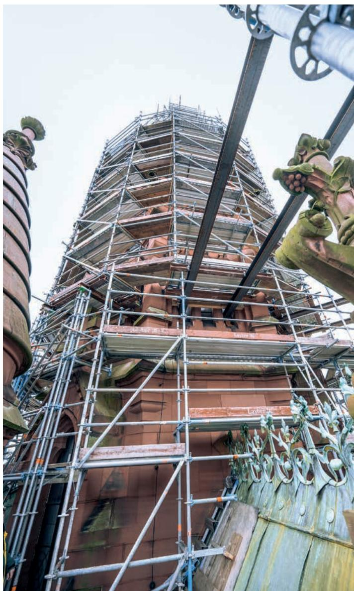
*Das Gerüst ist komplett aus Layher Standardbauteilen erstellt, mit denen man sehr flexibel auf alle Anforderungen auf der Baustelle reagieren kann.*
