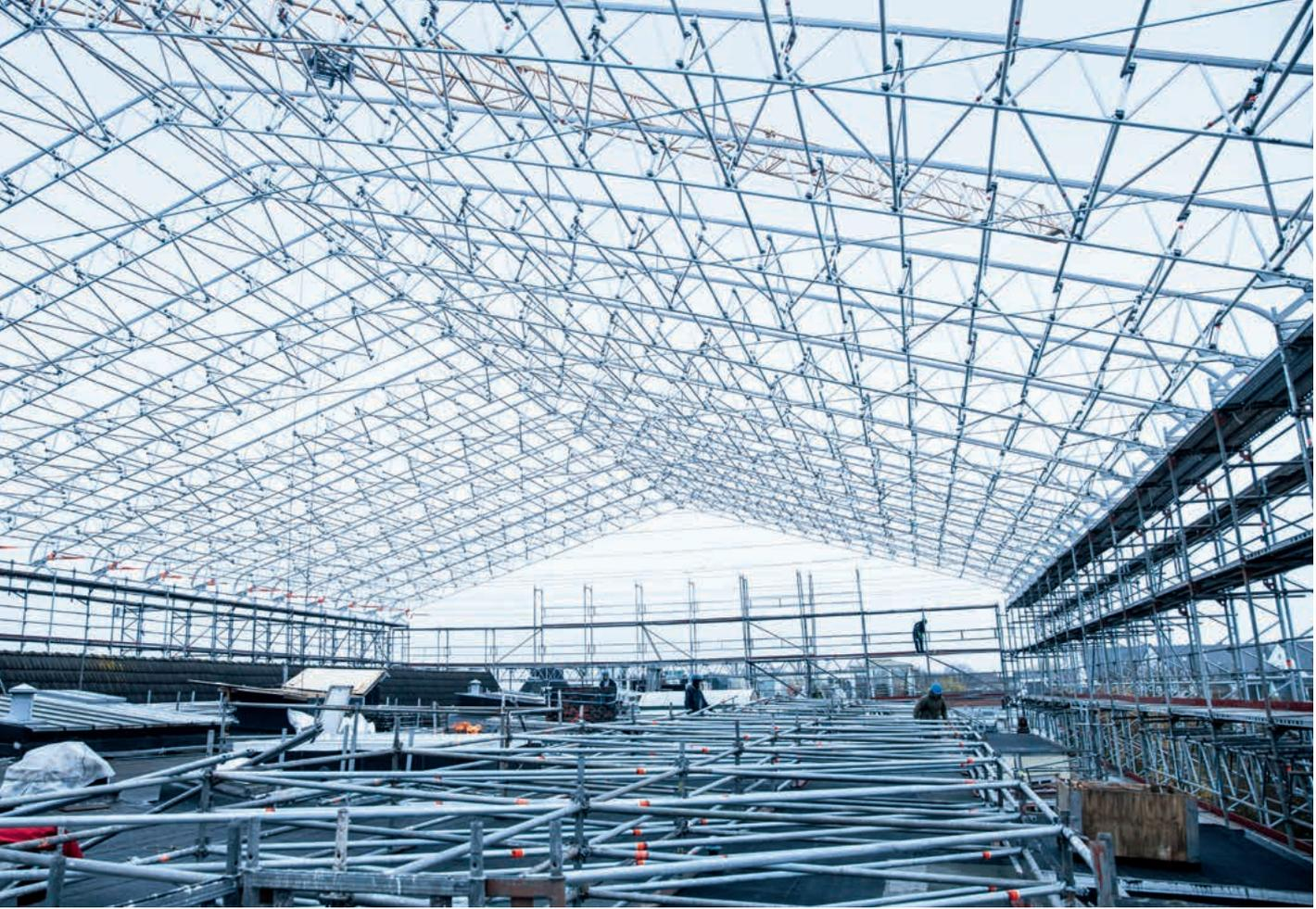
Das über 2.000 m<sup>2</sup> große Kederdach XL wurde direkt auf dem freistehenden Blitz Gerüst montiert und drei „Gerüstische“ eingehängt.
