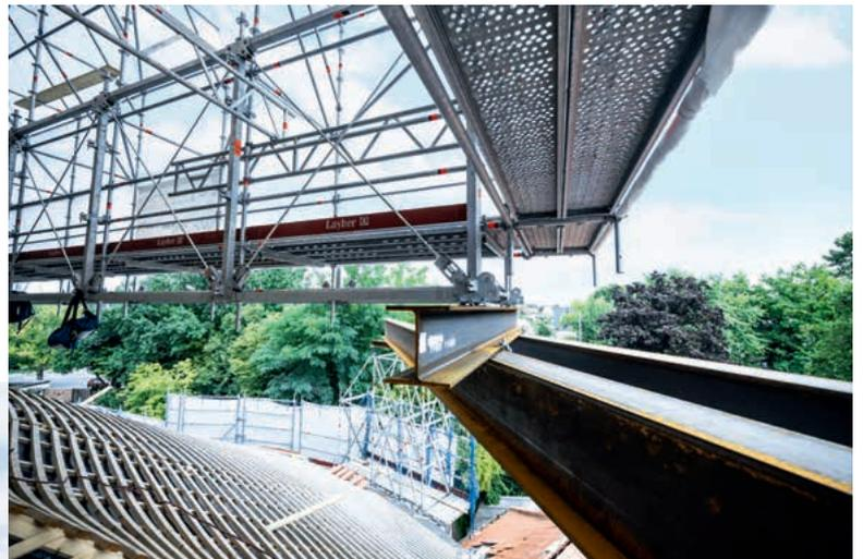
HEB 600 Stahlträger dienen als Auflage für den Layher Allround Brückenträger.
