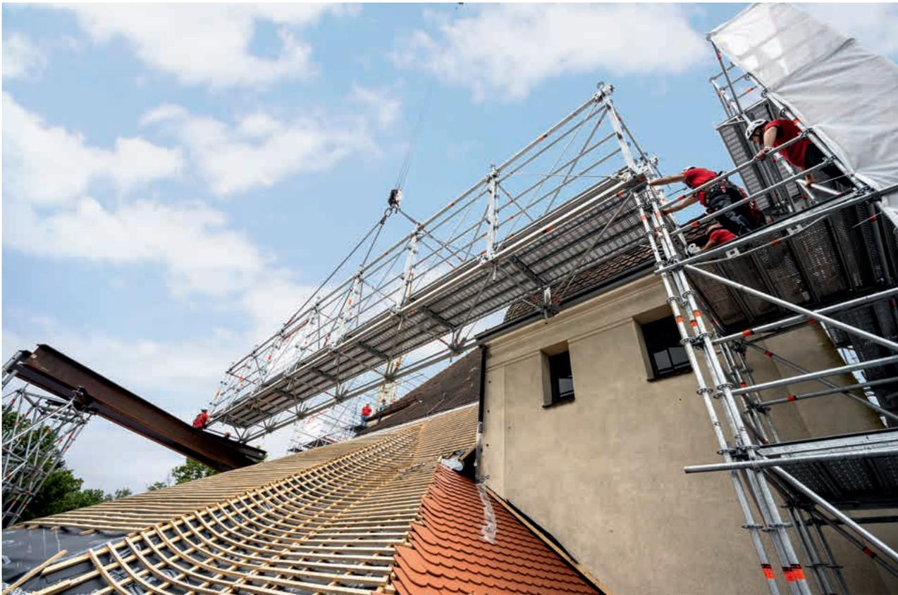
Millimeterarbeit am Autokran zur Platzierung des Layher Allround Brückenträgers zur Überbrückung der Dachfläche. Passt genau.
