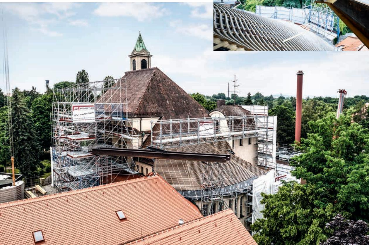
Das Krematorium wurde für die Sanierung von Fassade und Dach sehr aufwendig eingerüstet.
