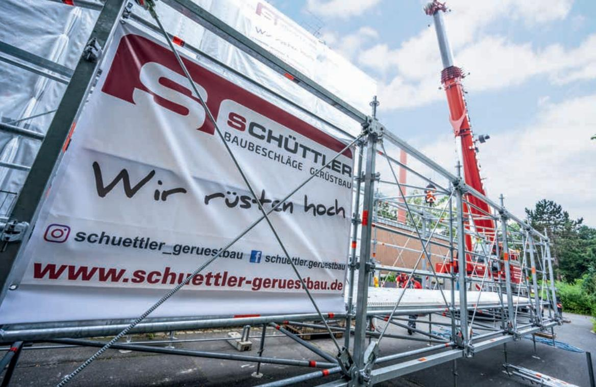
Der Layher Allround Brückenträger wurde sicher am Boden vormontiert, bevor ein Kran ihn an die richtige Position im Gerüst platziert.
