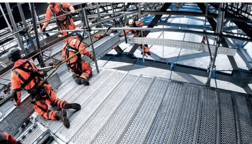
*Das Team von I-Scaff konnte mit dem Integrierten System von Layher am Tag doppelt so viel Fläche montieren wie in den vorherigen Montageabschnitten ohne den Aluminium-Träger FlexBeam.*
