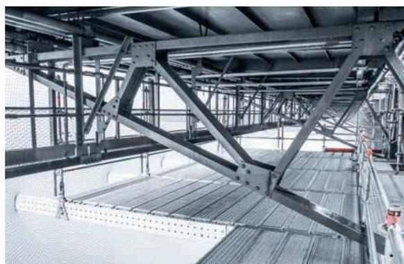
Die Konstruktion mit dem Aluminium-Träger FlexBeam und Layher Systemböden ermöglichten großzügige Arbeitsbereiche ohne störende Hindernisse.
