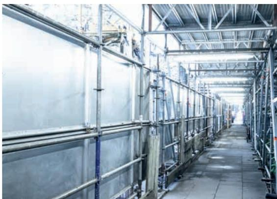
*Passanten-Tunnel aus Layher AllroundGerüst und Protect-System Elementen.*
