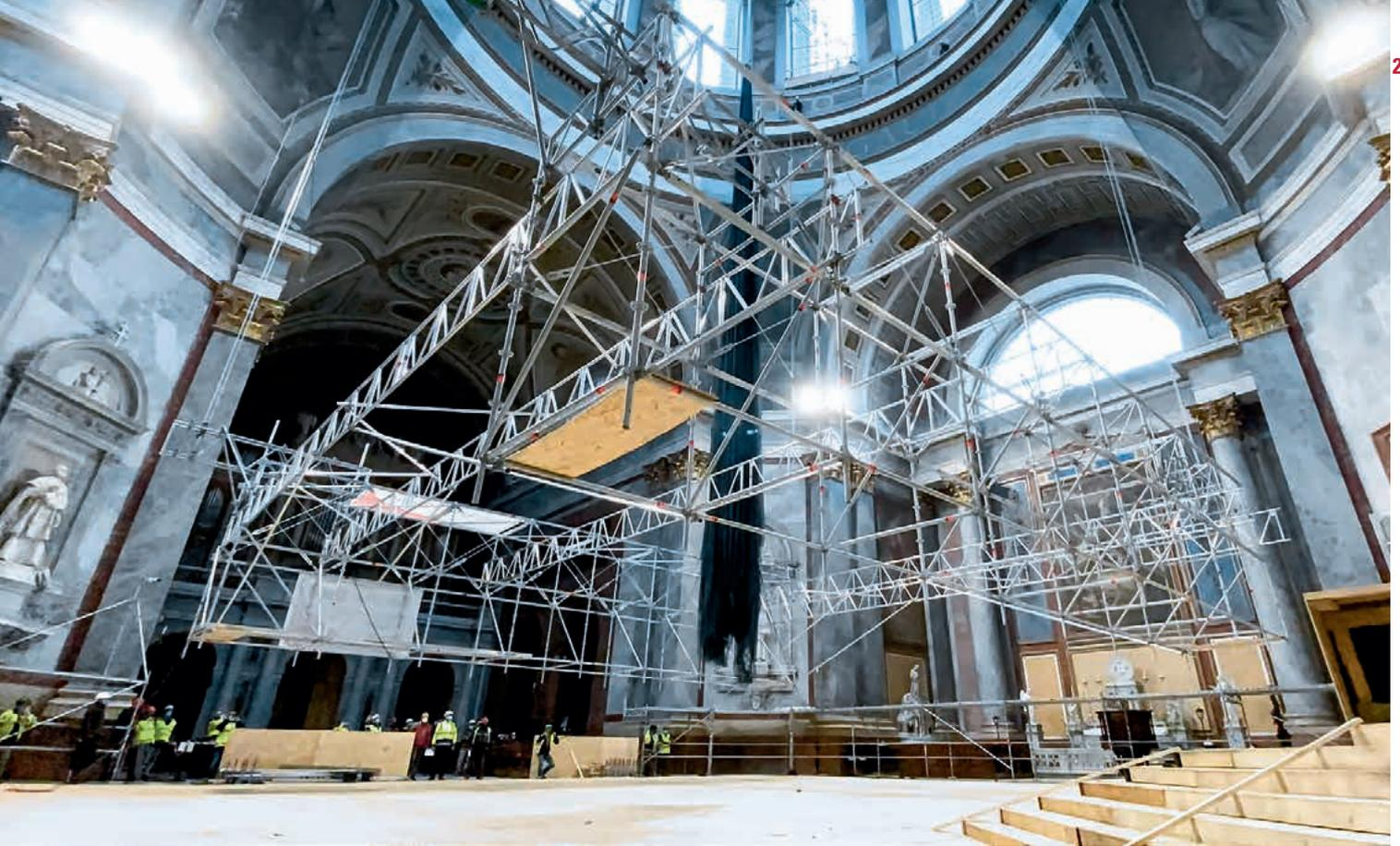
Die leichte Montagebrücke wurde am Boden der Kirche vormontiert und mithilfe von Winden auf eine Höhe von 34 m gehoben und dort verankert.
