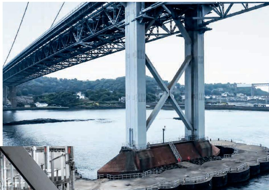
*Mit dem Aluminium-Träger FlexBeam und Layher Stahlböden wurden schnell und sicher Arbeitsplattformen für die Sanierung der Instandhaltungsbrücken erstellt.*
