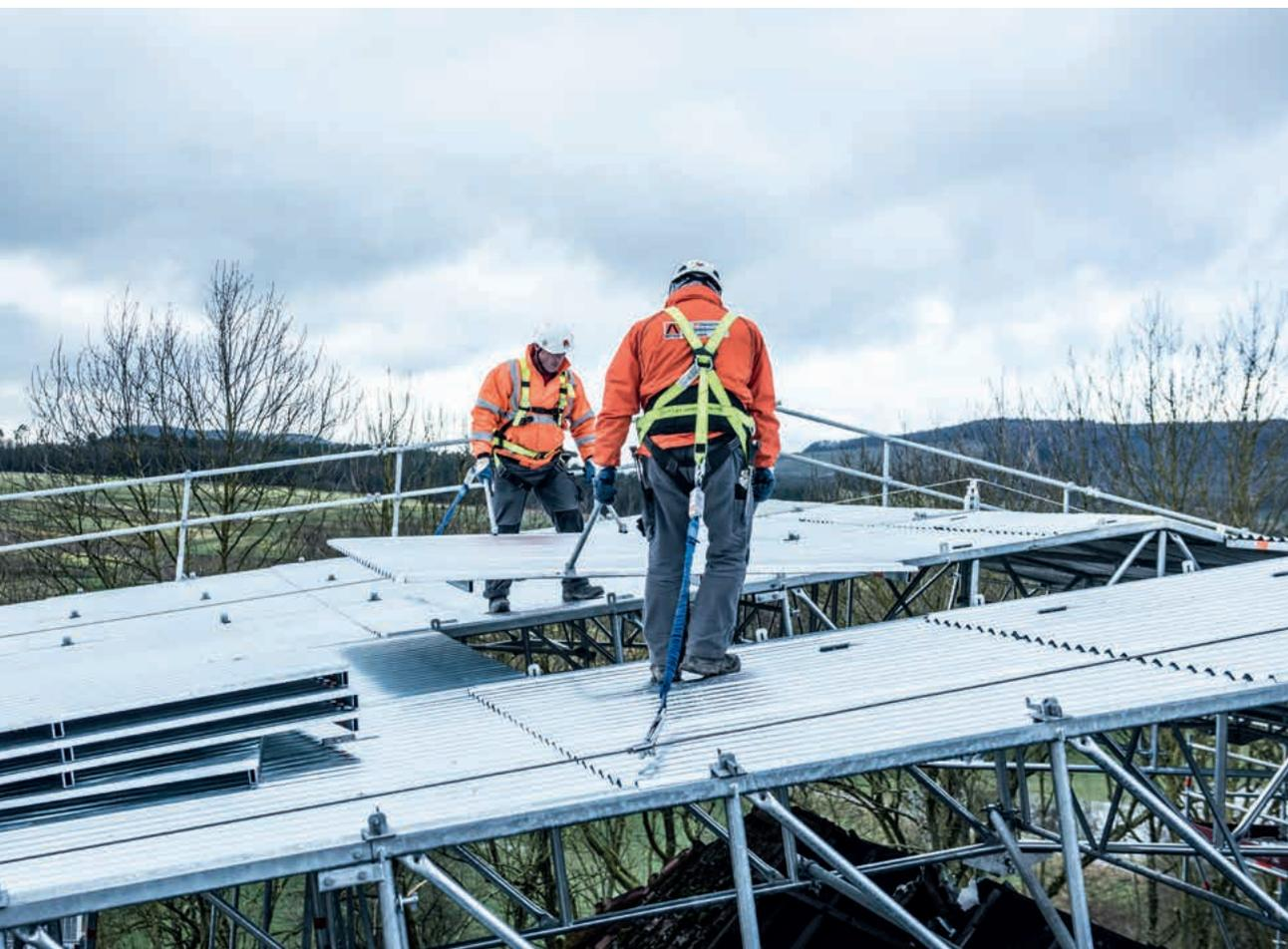
*Die Zwischenfelder werden schnell und aus gesichertem Stand mit Dachkassetten ausgelegt. Sie lassen sich z. B. zur Materialbestückung per Kran auch im Nachhinein einzeln entfernen.*
