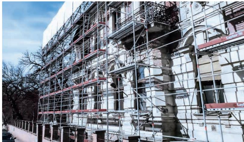
Die Fassadenseite wurde schnell und wirtschaftlich mit Blitz Gerüst eingerüstet, das als Stützgerüst für das Kederdach XL dient.
