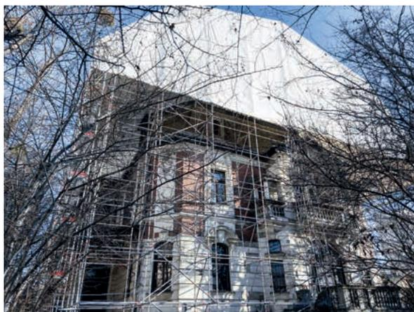
Für die Giebelseite wurde auf Grund der hohen Windlast und der stark gegliederten Architektur das AllroundGerüst eingesetzt, das mit Standardbauteilen eine einfache und flexible Geometrieanpassung ermöglicht.
