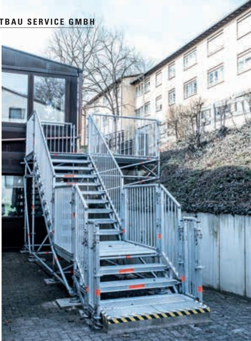
►► Auf Basis des bewährten Layher Allround-Gerüsts lassen sich Treppenkonstruktionen flexibel an verschiedene Gebäudegegebenheiten wie z. B. Austrittshöhen anpassen. Der Treppenturm 750 von Layher eignet sich aufgrund seiner Steigungsmaße und Tragfähigkeitswerte optimal für Fluchttreppentürme. Gegenüber Spezialanfertigungen aus Stahl und Holz bietet das modular aufgebaute Layher AllroundGerüst Vorteile wie die schnelle und wirtschaftliche Montage.
