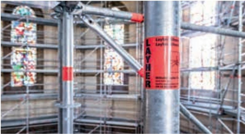
Die oberste begehbare Etage des Gerüsts befindet sich auf 37,50 m Höhe, direkt unter der Decke des Hauptschiffs und ermöglicht den Handwerkern und Restauratoren einen einfachen und sicheren Zugang zu ihrem schwindelerregenden Arbeitsplatz.
