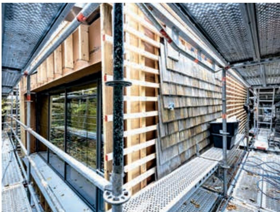
*Der gesamte Komplex wird mit vorgealterten Schindeln verkleidet, um möglichst sofort eine Einheit mit dem umgebenden Wald zu erzeugen. Das Layher Allround Gerüst und flexibel montierbare Konsolen erleichtern den Zimmerleuten dabei das Arbeiten erheblich.*
